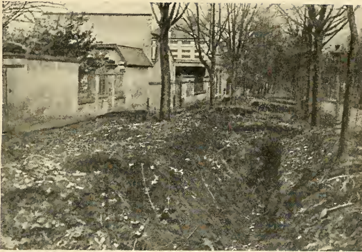
TRENCH IN THE BOULEVARD JEANNE D'ARC.
