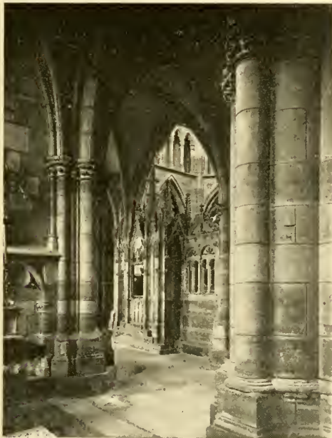
Interior View of Nôtre-Dame de l'Épine
