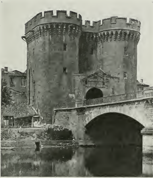
THE PORTE CHAUSSÉE (before the war).
