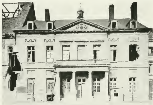
PÉRONNE. THE HÔTEL-DE-VILLE. The front facing the Rue Saint-Sauveur.
