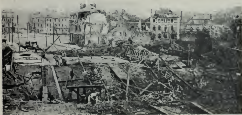
APRÈS LA PRISE DE SAINT-QUENTIN. Le génie français établit une passerelle au-dessus du pont effondré du chemin de fer.
