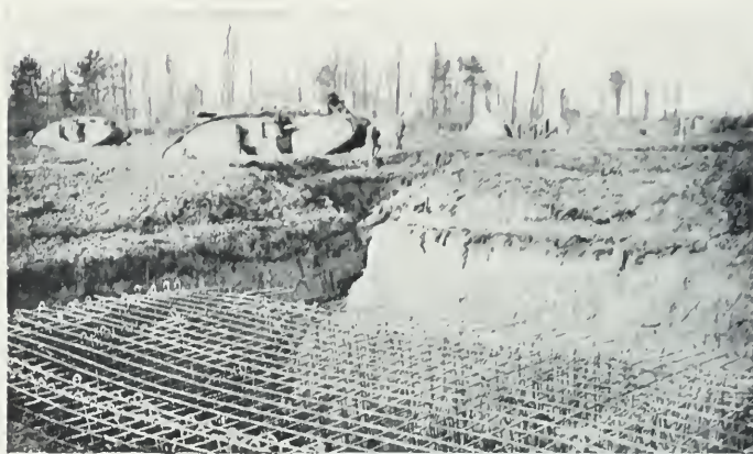
BLOCKHAUS ALLEMAND EN CONSTRUCTION : L'ARMATURE MÉTALLIQUE AVANT LE COULAGE DU BÉTON.
