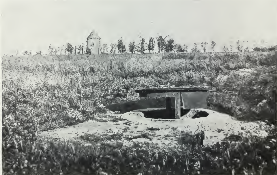
PUITS EN BÉTON ABRITANT UNE MITRAILLEUSE ALLEMANDE SUR ASCENSEUR. Au fond : LA TOUR DE PUZEUX, ORGANISÉE EN OBSERVATOIRE.
