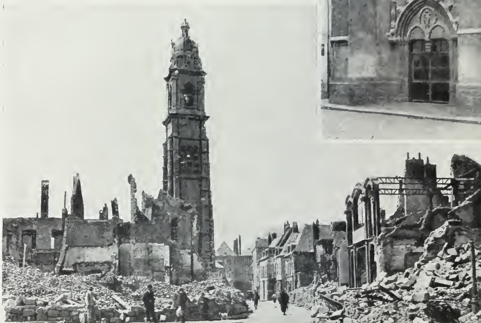
LE BEFFROI (TOUR ST-MARTIN) VU DE LA GRANDE-PLACE, ET SA PORTE D'ENTRÉE.
