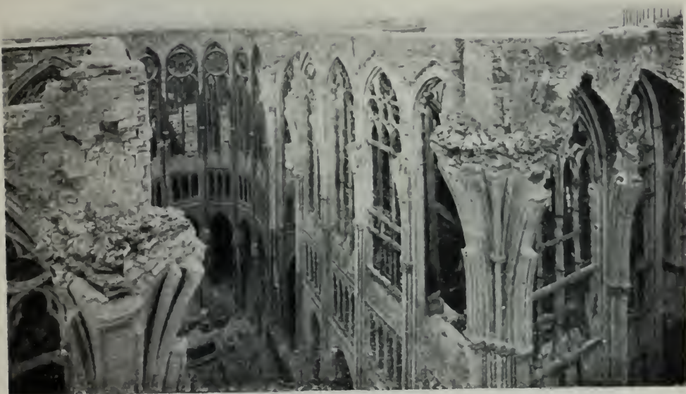
LA COLLÉGIALE. — LE CHŒUR DON'T LES VOUTES ET LA TOITURE SONT ÉCROULÉES.
