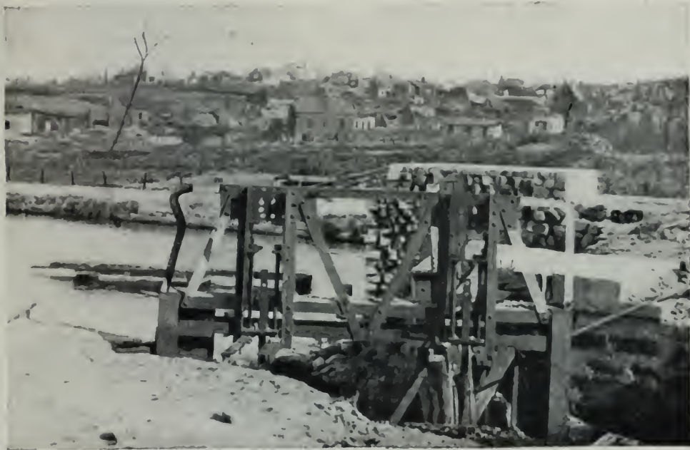
BANTOUZELLE. — LE CANAL DE SAINT-QUENTIN ; UNE ÉCLUSE DÉTRUITE. Au fond : BANTEUX.
