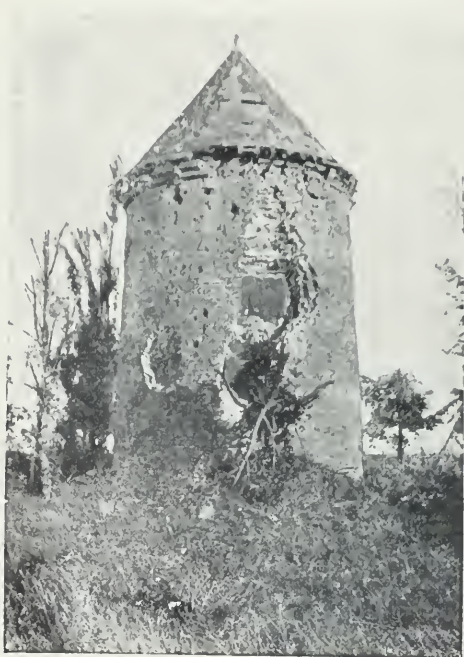
LA TOUR DE PUZEUX, DOUBLÉE INTÉRIEUREMENT PAR UN MUR EN BÉTON DE 1 m 80 D'ÉPAISSEUR.
