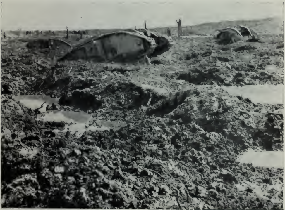
TANKS DÉTRUITS ET ENLISÉS, PRÈS DE LA ROUTE D'YPRES A MENIN.
