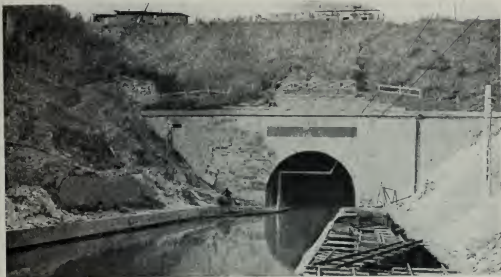
BELLICOURT. — L'ENTRÉE DU TUNNEL DU CANAL DE SAINT-QUENTIN REMIS EN ÉTAT AU DÉBUT DE 1920.
