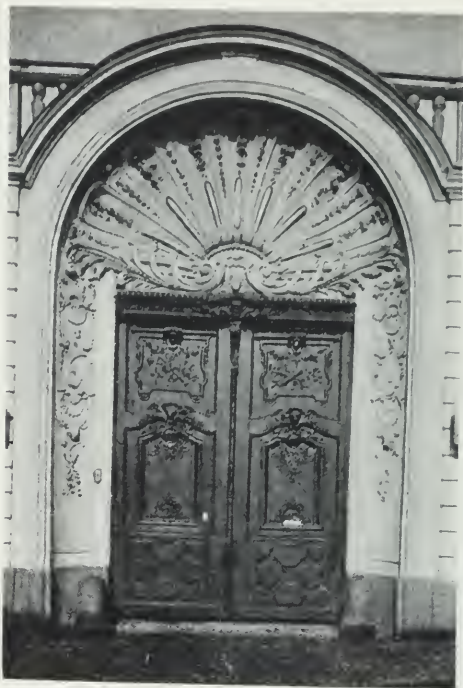
CAMBRAI, RUE CARNOT : UNE BELLE PORTE DU XVIII e SIÈCLE, détruite pendant l'incendie.
