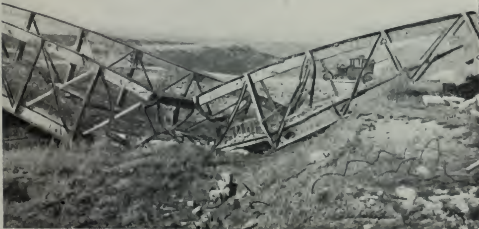
DEVANT MŒUVRES. — LE CANAL DU NORD ET LA ROUTE MŒUVRES-BOURLON.
