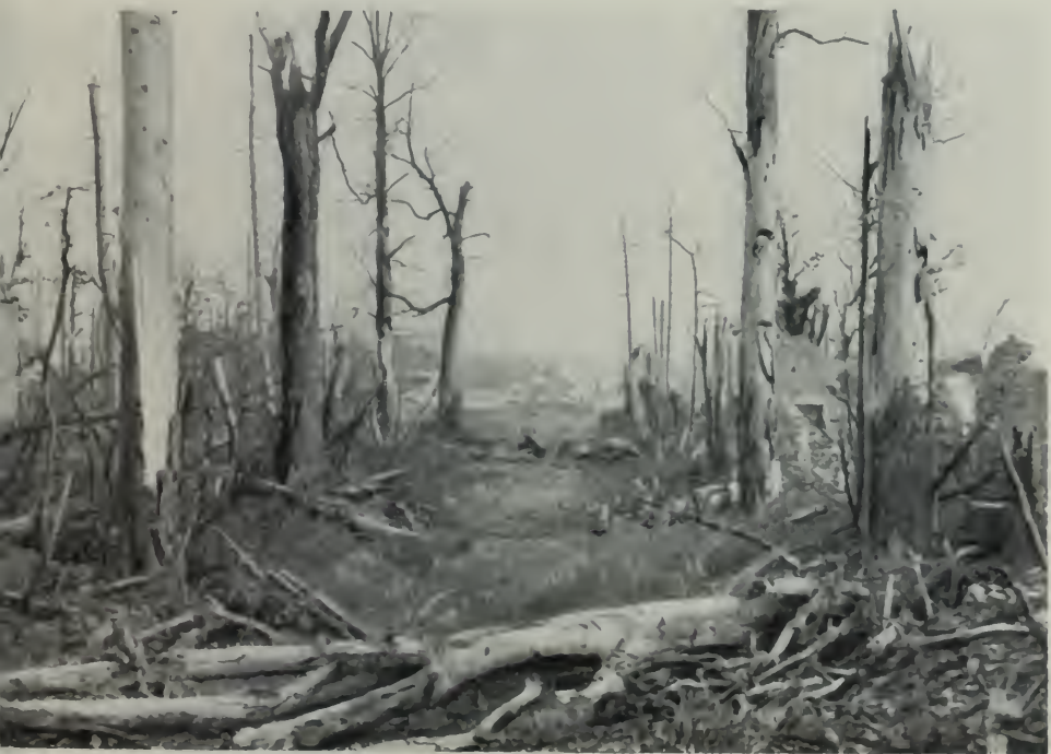
L'ALLÉE PRINCIPALE DU PARC. — Au fond : LE CHATEAU.
