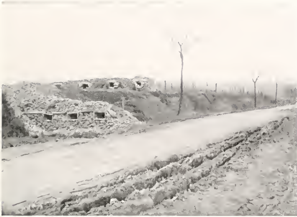
ST. THOMAS. ROUTE DE SERVON. WITH BARRICADES AND TRENCHES (Feb. 2, 1916).
