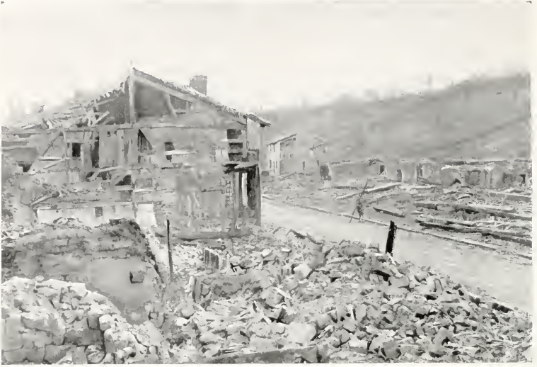
VIENNE-LE-CHÂTEAU. ROAD LEADING TO LA PLACARDELLE
